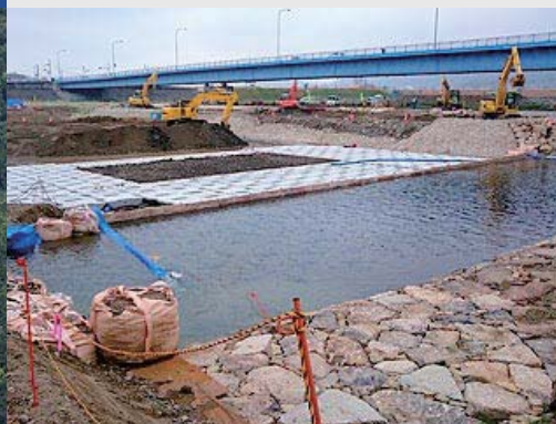
2017 年 9 月 21 日 旭川河川工事
